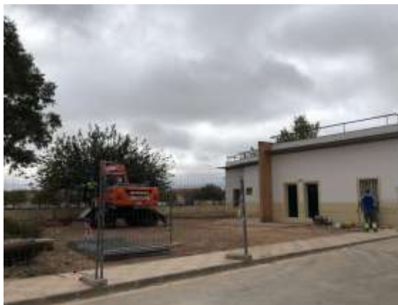
Zona exterior centro de salud (antes de la obra)
