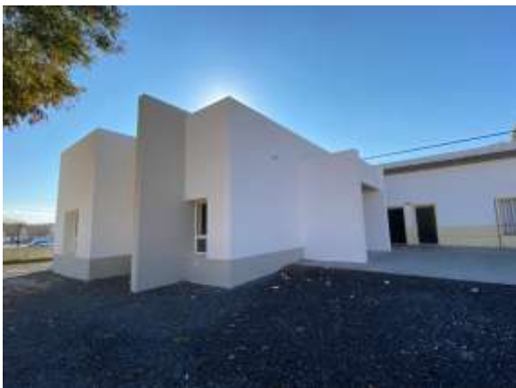
Zona exterior centro de salud (finalizada la obra)
