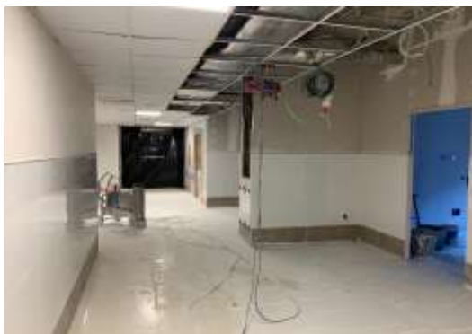
Pasillo exterior consultas en obras
