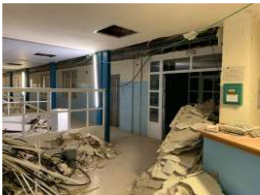
Zona consulta sin reformar
